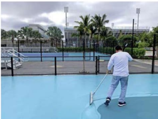
Nanesení prostředku LM Topcoat
