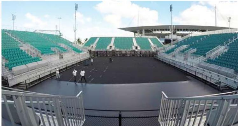
Nanesení prostředku Laykold Resurfacer
